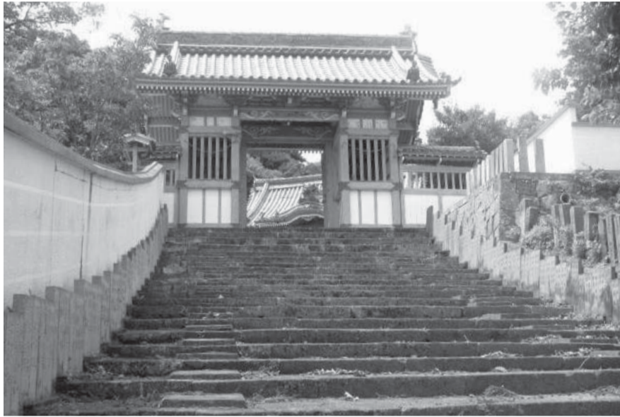
来春修繕予定の随神門
